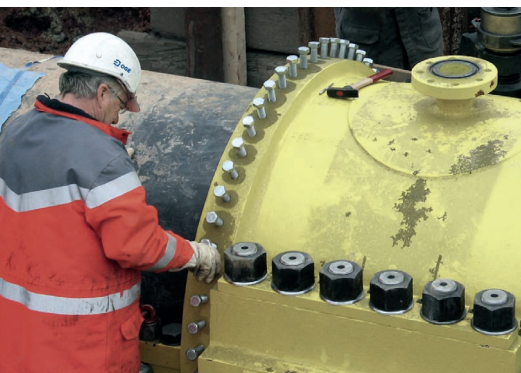
Leitungssicherung mit Reparaturüberwurf
